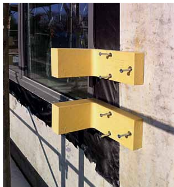
Abb. 2: Tragender Kunststoff-Winkel in Einbausituation
