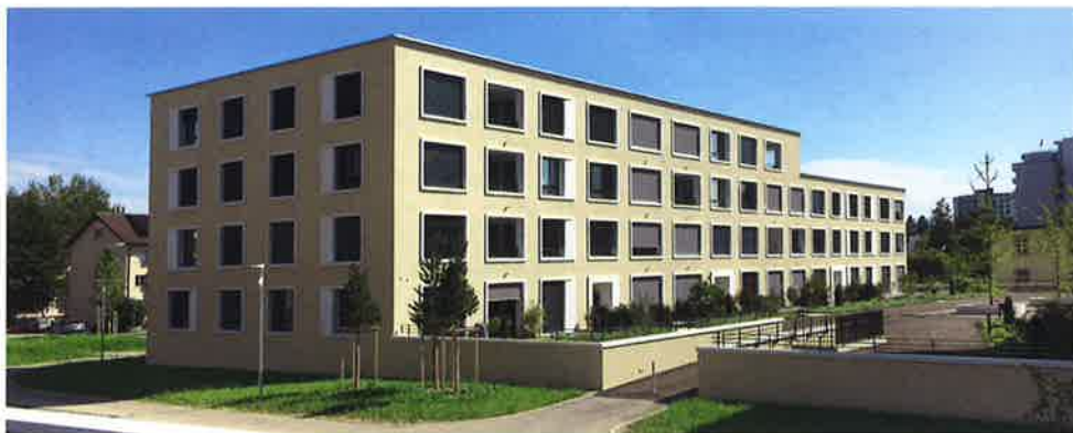
Überbauung Altstattwiese, St. Gallerstrasse 13 bis 17c, 9500 Wil.
