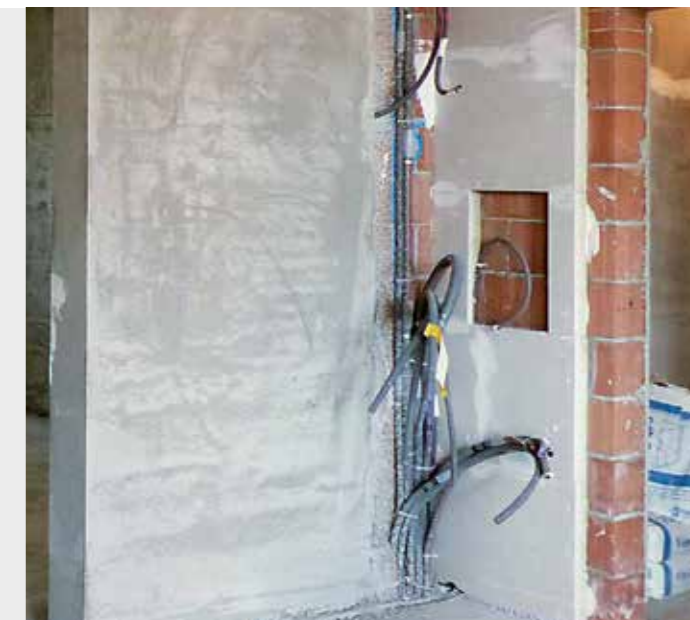
Leitungsführung in Vorsatzschale.
