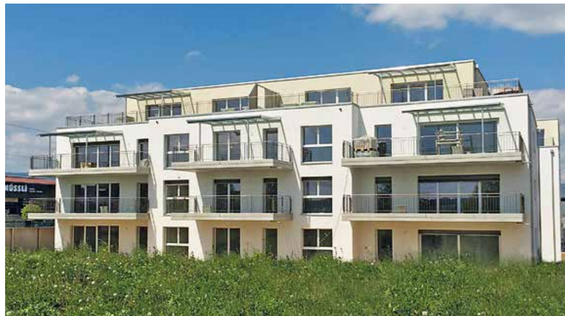
Mit dem Wandsystem Seismur ausgeführte Überbauung Stigli-Spinsmatte in Lyss.
