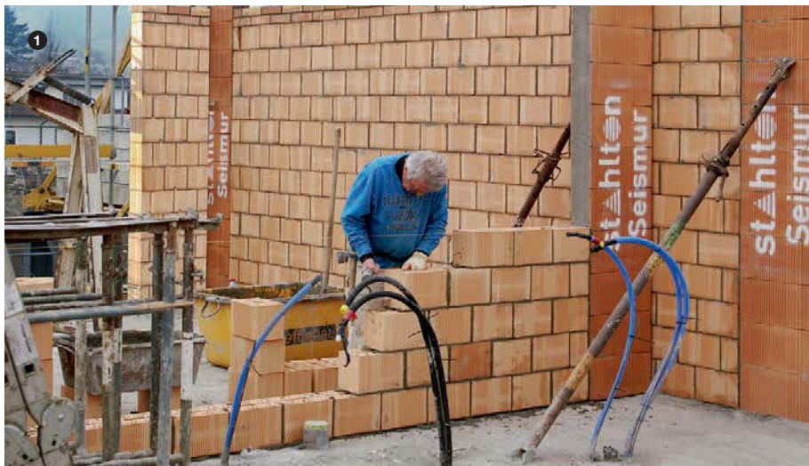
1 Mauerwerk mit «Seismur». 2 Mit biegeweicher Vorsatzschale.
