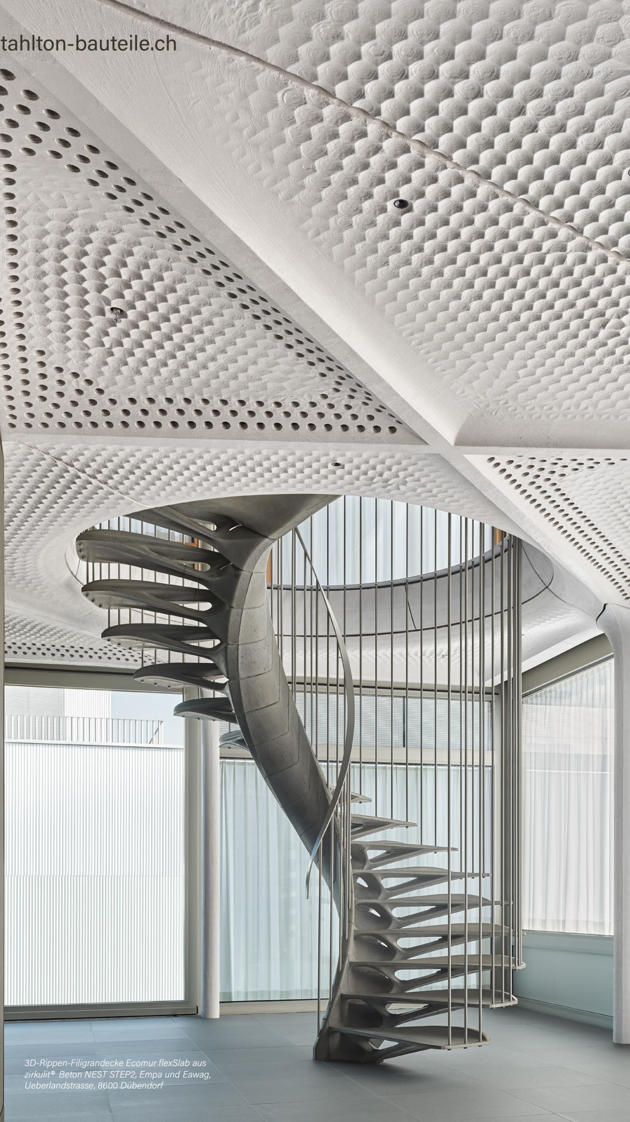
3D-Rippen-Filligrandecke Ecomur flexSlab aus zirkulit® Beton NEST STEP2, Empa und Eawag, Ueberlandstrasse, 8600 Dübendorf
