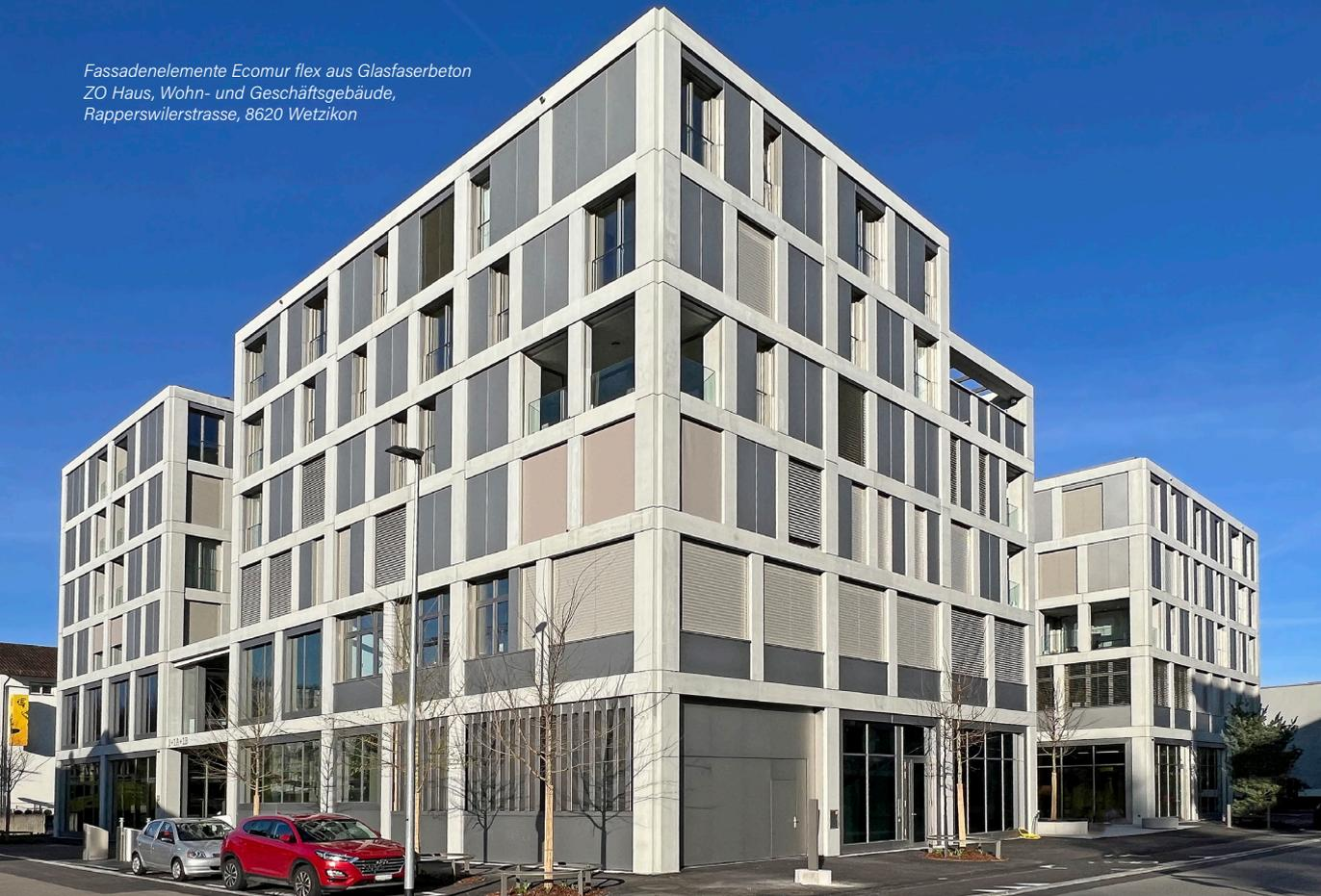
Fassadenelemente und -Profile Ecomur flex aus Glasfaserbeton ermöglichen einen einzigartigen Gestaltungsspielraum mit grossflächigen, dünnwandigen, 2- und 3-dimensional geformten Bauteilen. Diese können in 10 unterschiedlichen Farbtönen durchgefärbt sowie in modellglatten oder strukturierten Oberflächen hergestellt werden. Fassadenelemente Ecomur flex erfüllen die Anforderungen von ecobau und Minergie-Eco und sind mit dem Label «eco 2» bewertet.
